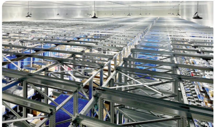
Regalanlage eines fünfgeschossigen automatischen Tiefkühlagers mit -22\text{ }^{\circ}\text{C} von oben. Foto: Klinkhammer
