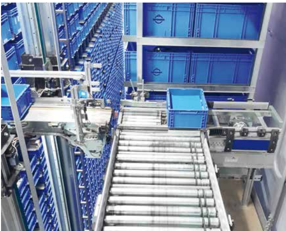
Behälterübergabe an Fördertechnik
