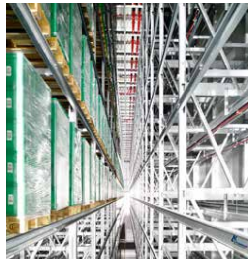
11.000 Palettenstellplätze im automatischen Hochregallager
