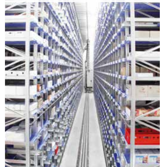
2-gassiges, automatisches Tiefkühlager
