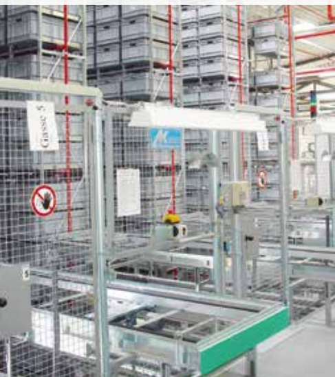
Das Hochregallager bei Dräxlmaier mit 7980 Behälterstellplätzen
