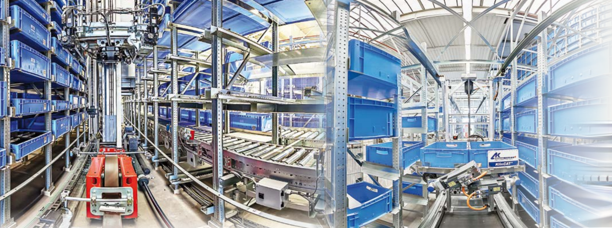
Automatisches Kleinteilelager mit Regalbediengerät
