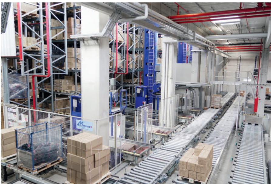
Vier-gassiges automatisches Palettenhochregallager mit über 9.000 Stellplätzen.
