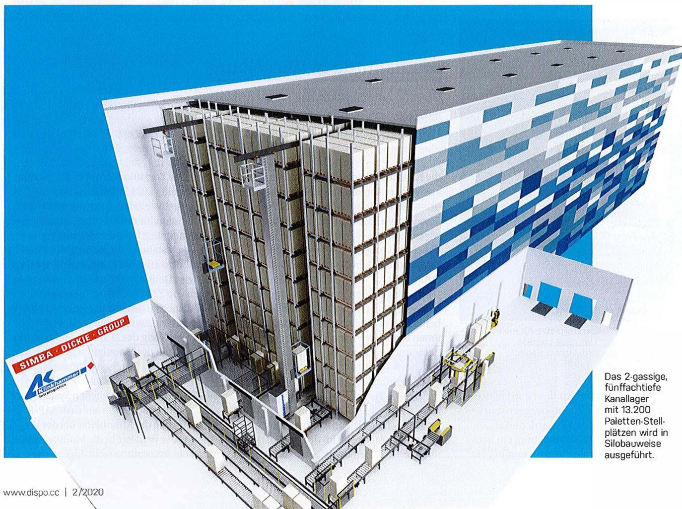
Das 2-gassige, fünffachtiefe Kanallager mit 13.200 Paletten-Stellplätzen wird in Silobauweise ausgeführt.
