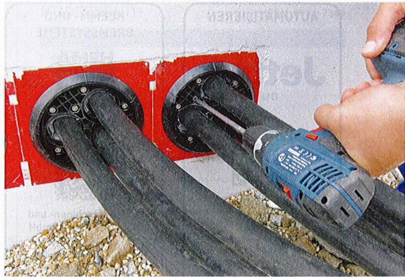
Abdichtsysteme für Kabel, Rohre und Hauseinführungen schützen Gebäude vor eindringendem Wasser, Gas, Feuer, Schmutz und Ungeziefer.
