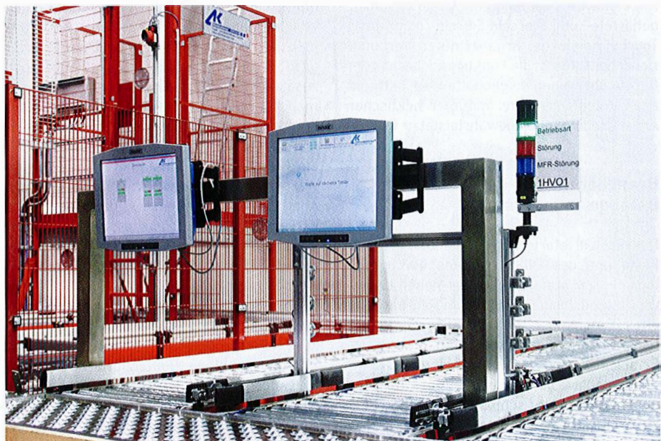
Fördertechnik-Vorzone mit Kommissionierarbeitsplatz
