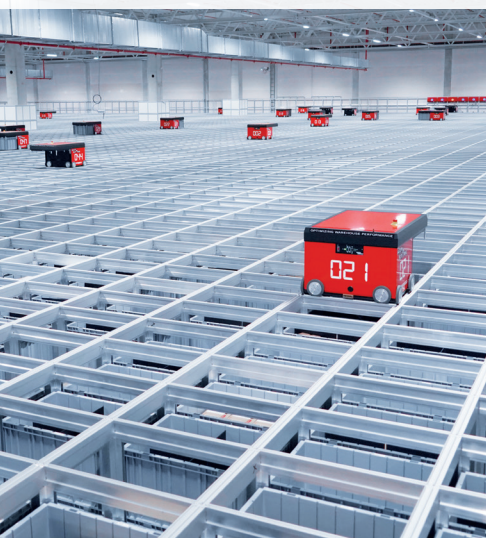
Autostore-Lager mit 110 Fahrzeugen
