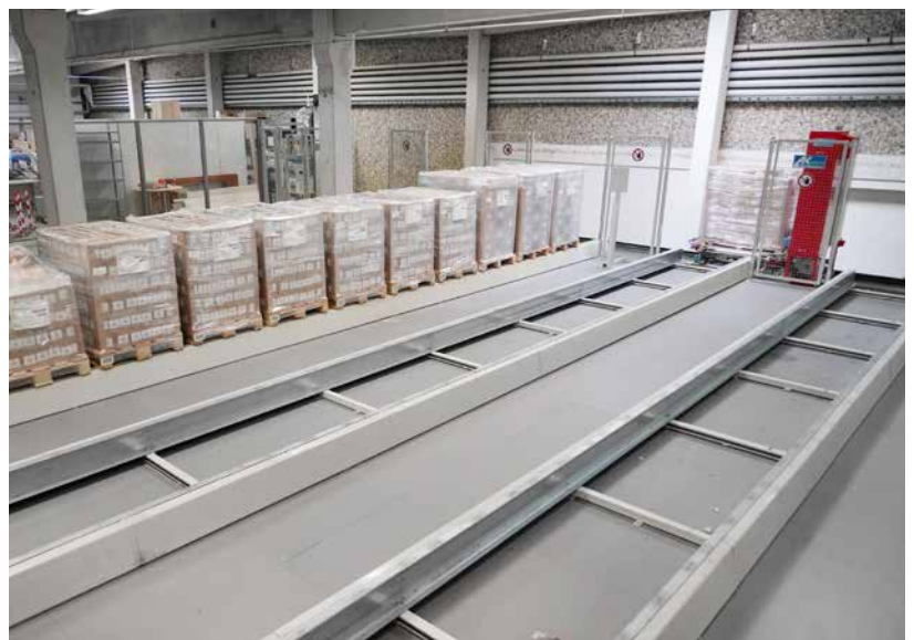
Wareneingang mit Bereitstellungsbahnen für 80 Palettenstellplätze
