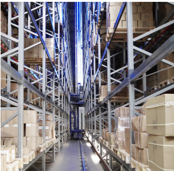
Retrofit des automatischen, 2-gassigen Palettenhochregallagers im laufenden Betrieb
