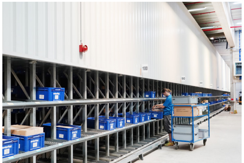
Retrofit des 1-gassigen, automatischen Kleinteilelagers mit seitlichen Durchlaufkanälen
